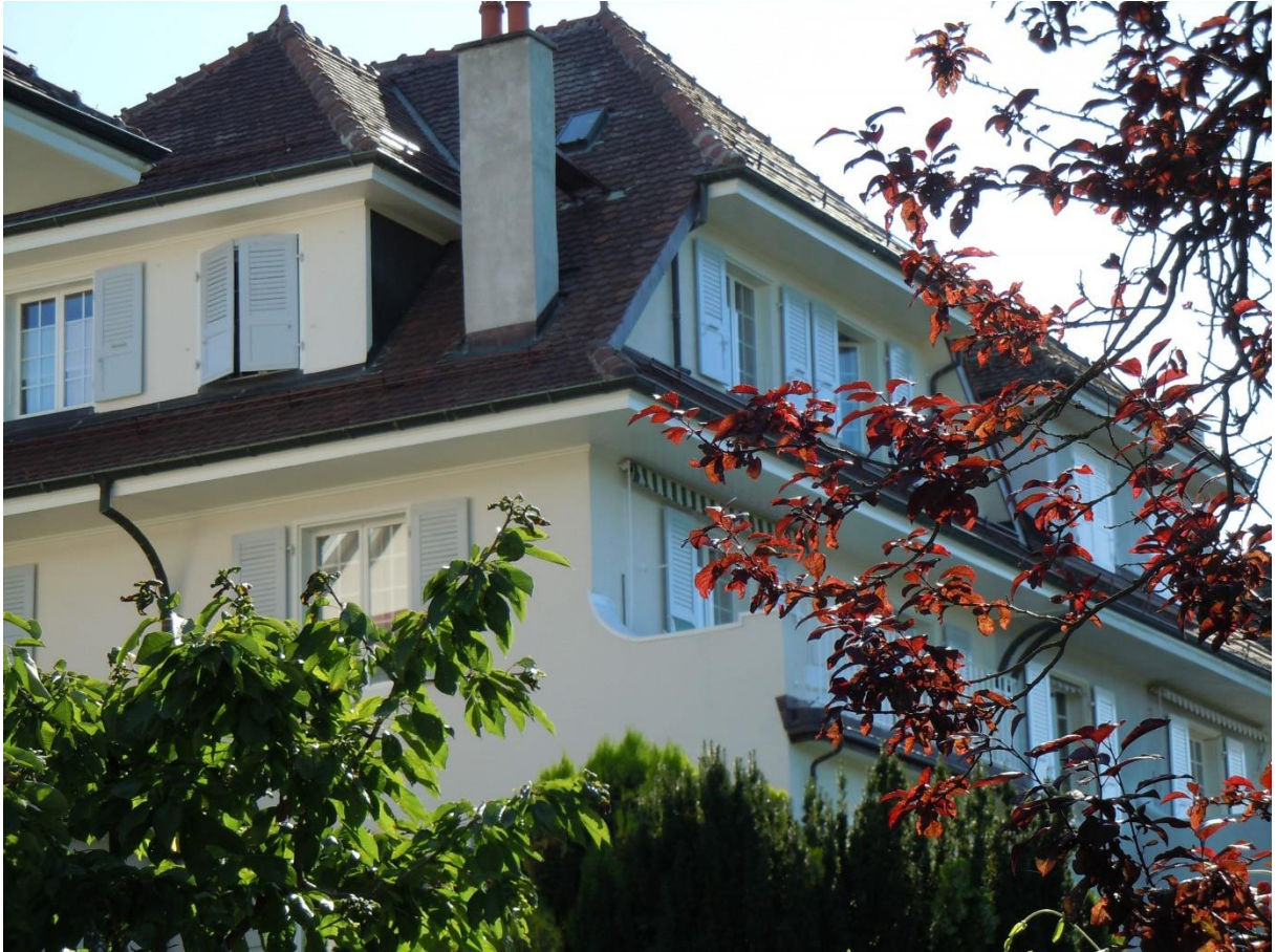
Obere Stockwerke des Hauses von AEMISEGGER
