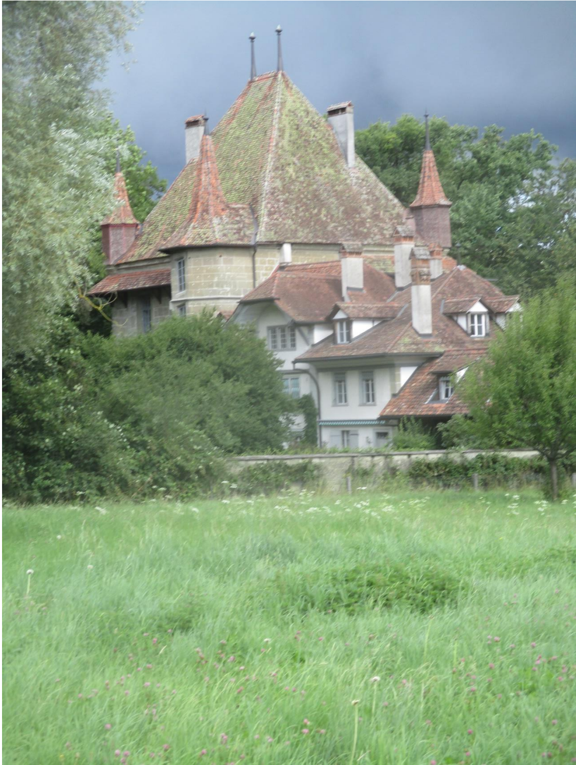
Ansicht aus Südwesten
