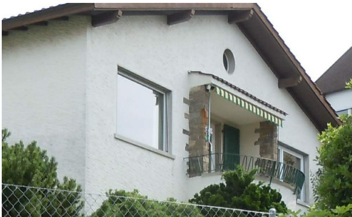
Vue sur la villa du sud-ouest
