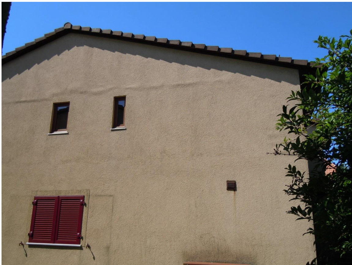
Façade est de la villa mitoyenne de CREUX
