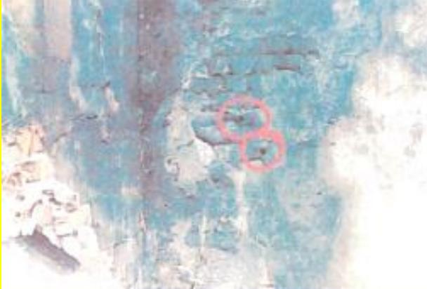
Les perforations de BUDRY à travers le mur mitoyen, aboutissant dans le canal d'aération – côté écurie de GUTKNECHT
